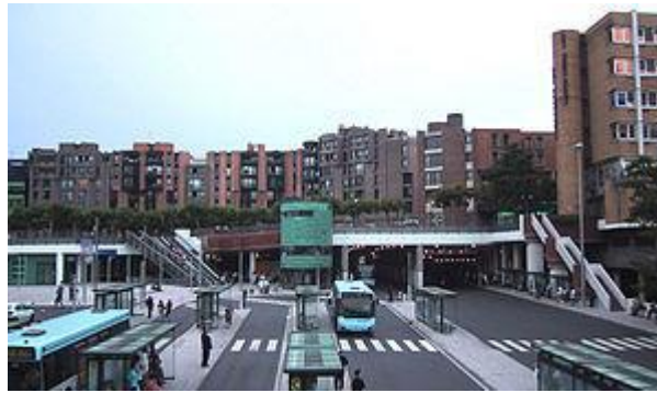
Figure 10 : Illustration de la dalle de Cergy au niveau de la gare routière, les voies qui sont au niveau du terrain naturel, passent sous la dalle et les constructions, facilitant ainsi la connexion entre les deux quartiers de la ville, source, ville de Cergy-Pontoise.
